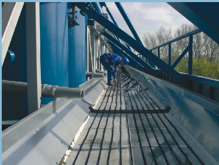
Przykład ułożenia przewodów grzewczych w korycie dachowym
